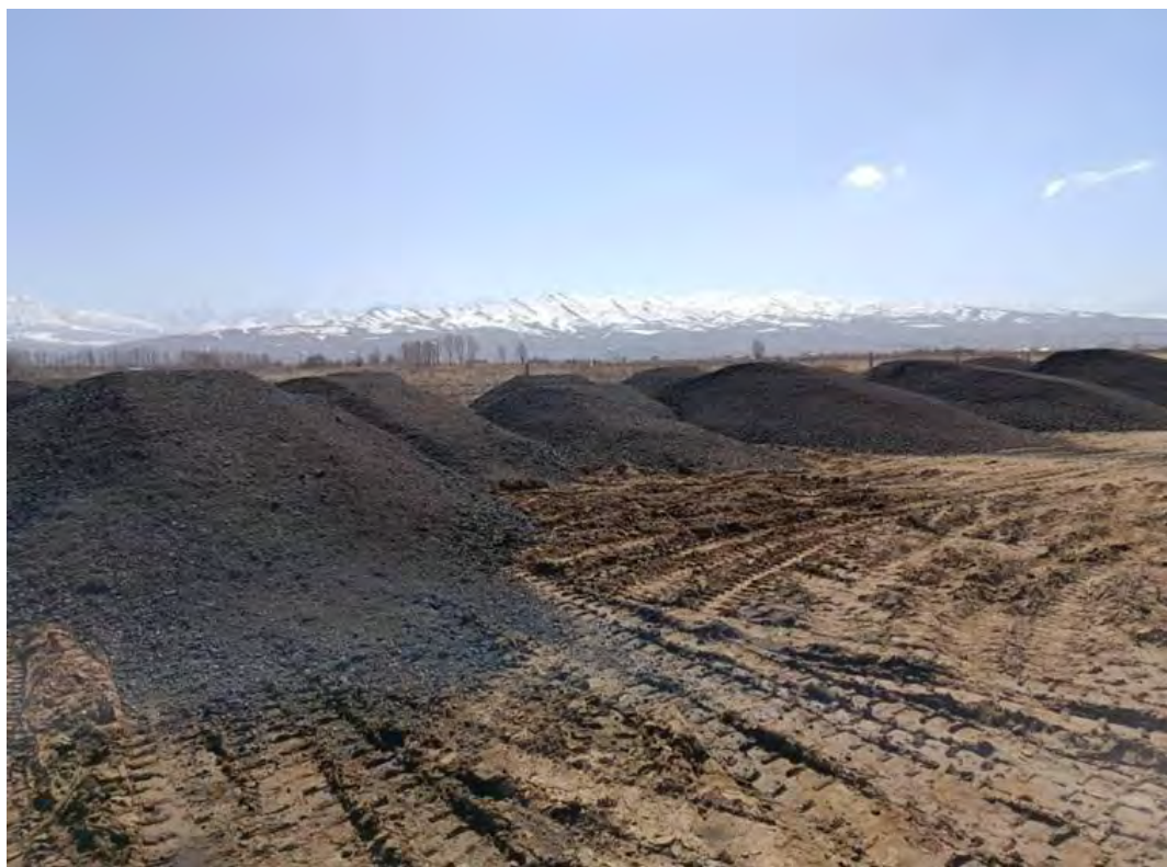
Рисунок 8: Накопление имеющегося асфальтобетонного материала после фрезерования, км 195+000, п.с.
