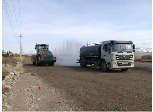
Фото 50. Гидроорошение участков дороги с км.182+860-км.215,8.
