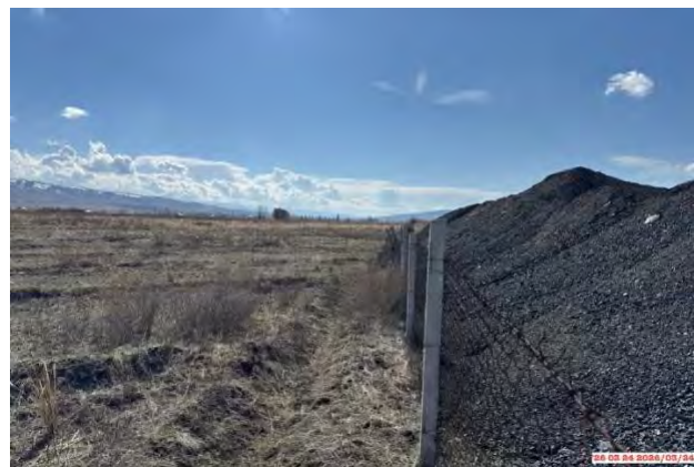
Фото 66. Отвал асфальта на км.199+500. Асфальт складирован на границе с посевным полем. В результате складирования повреждено ограждение
