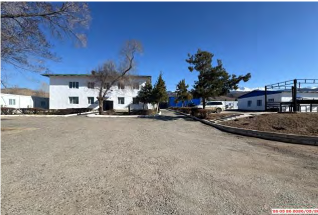
Фото 41. Лагерь строителей и офис в с.Ак-Терек, км. 152+700
