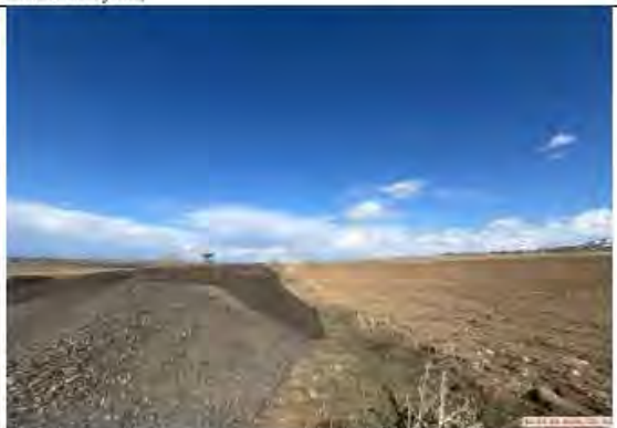
Фото 27. Отвал асфальта на км.194+600. Асфальт складирован в непосредственной близости с посевным полем. Границы отвала не отмечены
