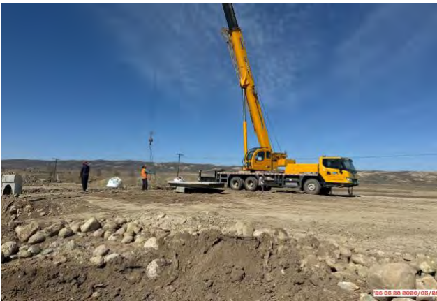
Фото 57. Вывоз демонтированных частей водопропускного сооружения на км. 194
