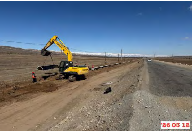
Фото 9. Установка лотков, км 187+460LHS
