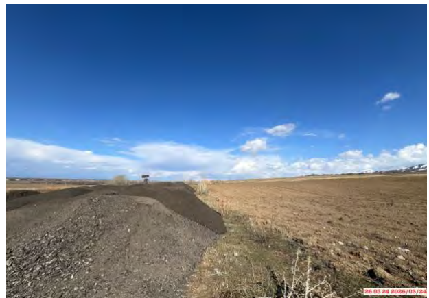
Фото 64. Отвал асфальта на км.194+600. Асфальт складирован в непосредственной близости с посевным полем.
