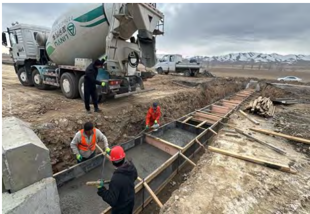
Фото 17. Бетонирование фундамента, 211+191
