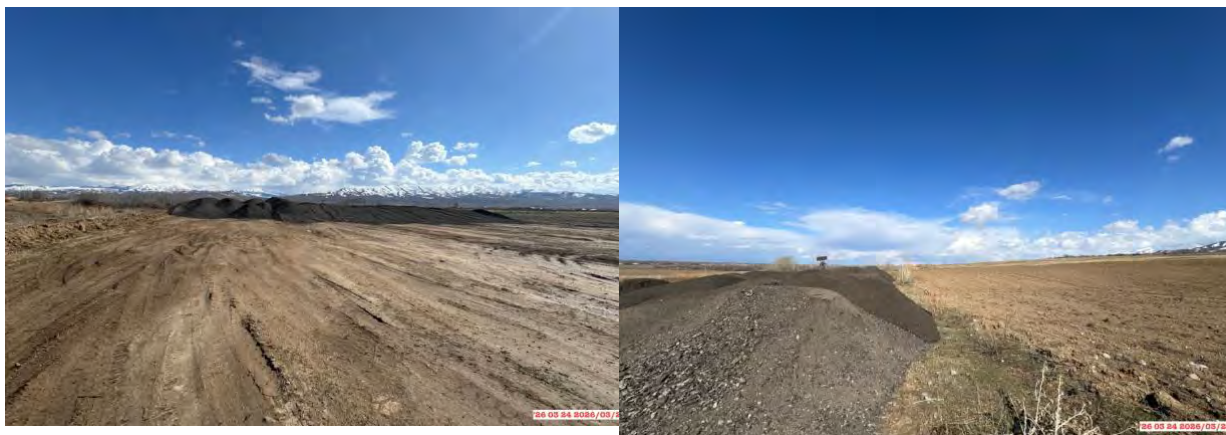
Рисунок 44: Складирование фрезерованного асфальта на строительных участках км 194+600 и км 199+500
