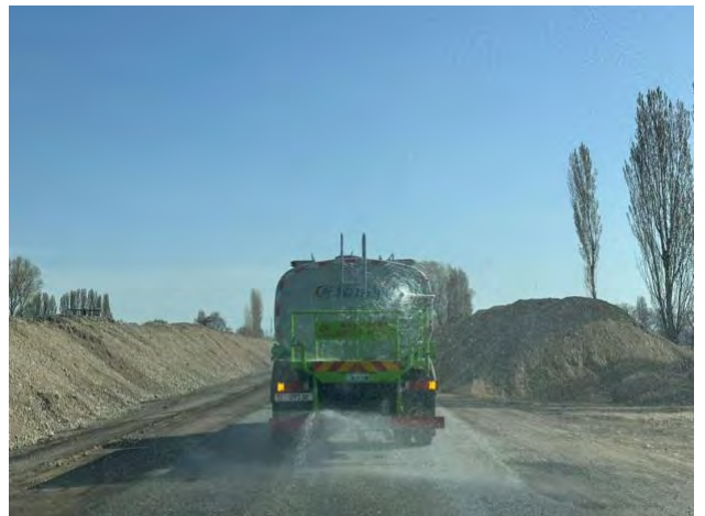
Фото 52. Гидроорошение участков дороги с км.182+860-км.215,8.
