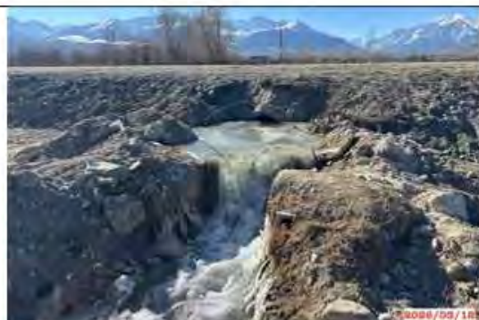
Фото 5. Водопроектная труба на км 140+760, выход
