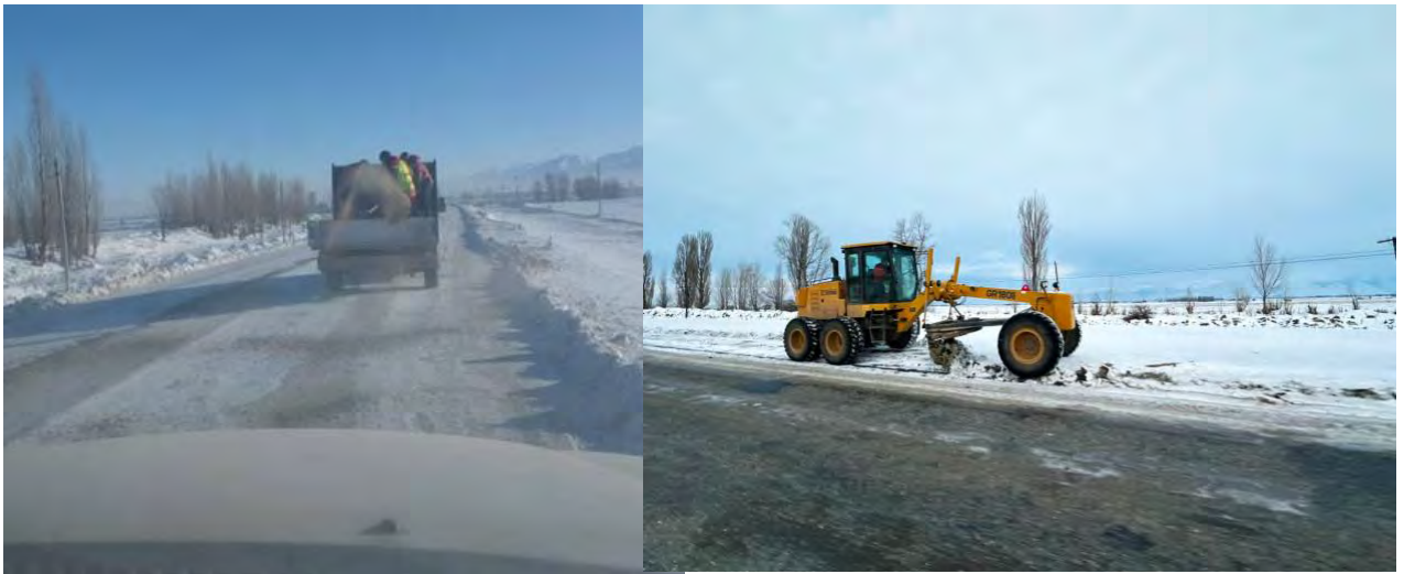
Рисунок 47: Очистка дороги от снега и посыпка инертным материалом на протяжении всего участка дороги
