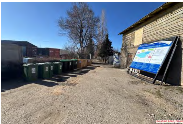
Фото 45. Лагерь строителей и офис в с.Ак-Терек, км. 152+700. Контейнеры для сбора отходов.
