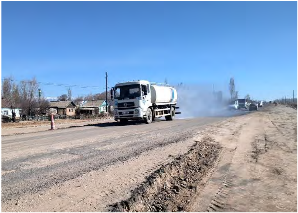
Рисунок 46: Подавление пыли участков проведения земляных работ для предотвращения плохой видимости на основной дороге
