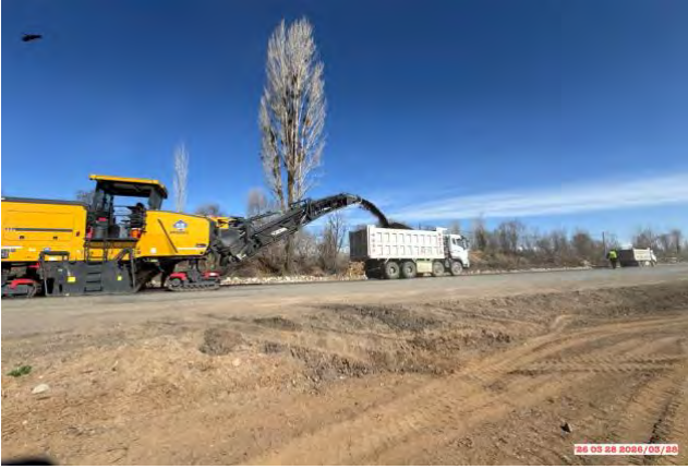
Фото 13. Фрезеровка асфальта км.203+300
