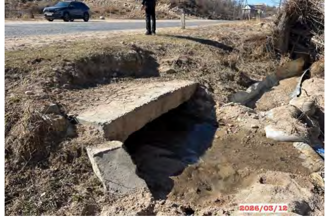
Фото 20. Селепропуск на км.151+020 LHS. Выход
