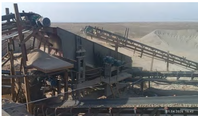
Фото 1. Работа ДСУ на производственной базе на км 167+360
