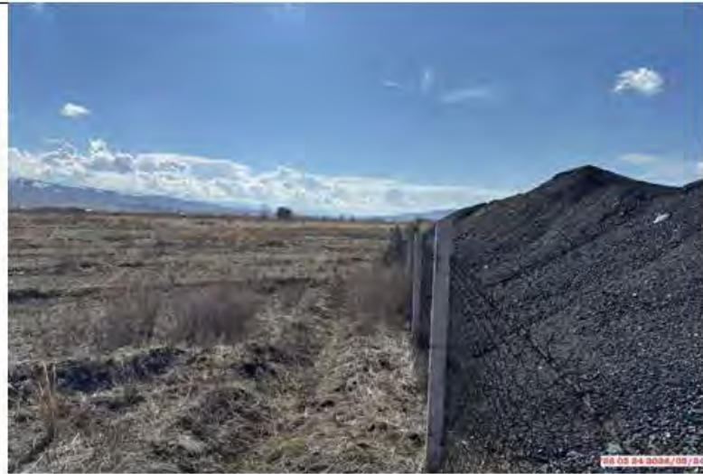
Фото 30. Отвал асфальта на км.199+500. Асфальт складирован на границе с посевным полем. В результате складирования повреждено ограждение
