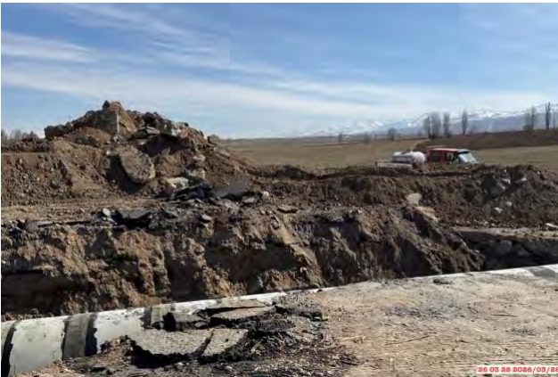
Фото 59. Складирование фрезерованного асфальта на строительных участках.
