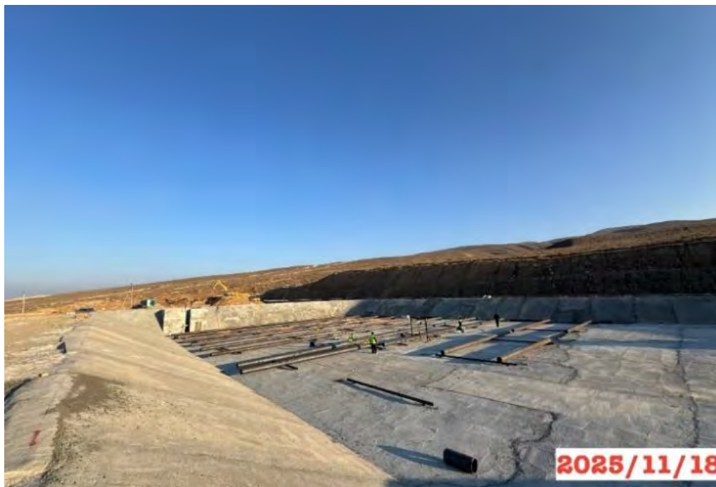
Рисунок 16: Производственная база, км 167+360 ПС, строительство битумного хранилища
