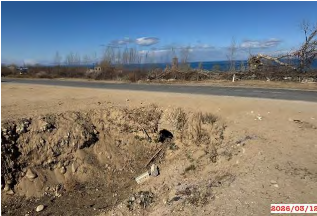
Фото 21. Селепропуск на км.151+260 RHS. вход
