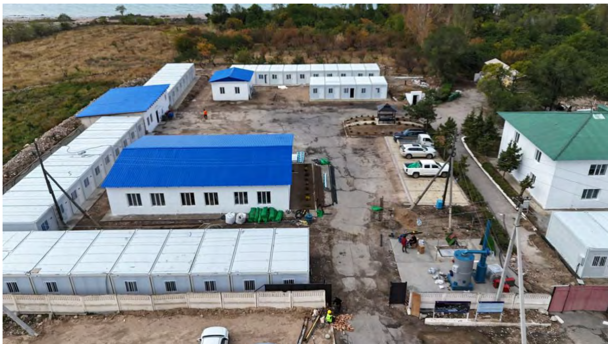
Рисунок 24: Вид сверху на территорию Лагерь в с.Ак-Терек, км 152+700 ЛС (Лот 1)
