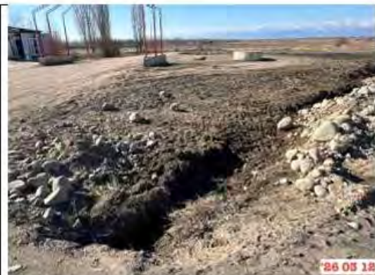
Фото 10. Водопропускная труба, на км.200+ RHS. Выход
