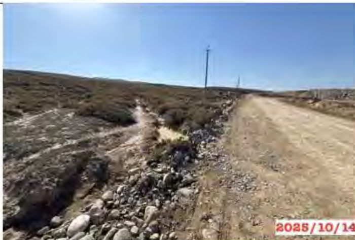
Фото 15. на склоне зафиксированы сформированные селевые (селеподобные) пути, представленные системой эрозийных каналов с признаками периодической активности. Руслу имеют выраженную направленность вниз по склону, местами сливаются, в их пределах наблюдается отсутствие устойчивого растительного покрова и наличие свежего обломочного материала (галка, щебень, суглинисто-глинистые массы).
