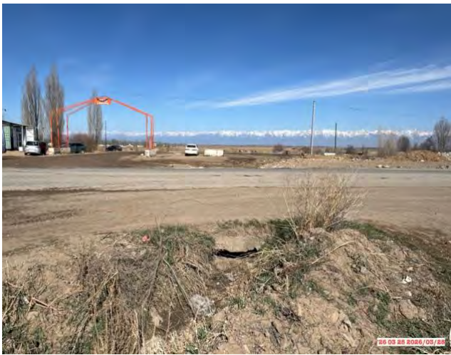
Фото 27. Водопропускная труба, на км.200+ RHS. вход
