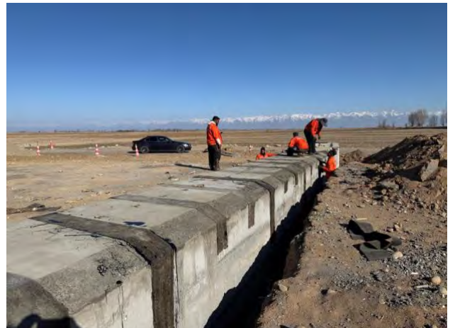
Фото 16. Гидроизоляция швов, км 204+400
