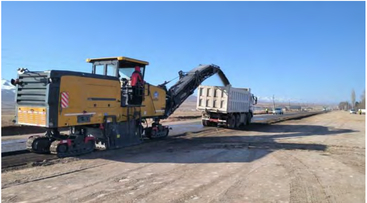
Рисунок 7: Фрезерование существующего асфальтобетонного покрытия на участке км 200+000.
