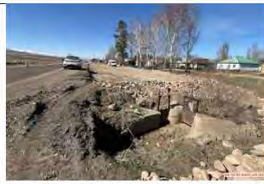
Фото 6. Водопроектная труба, на км.195+830 LHS, выход.
