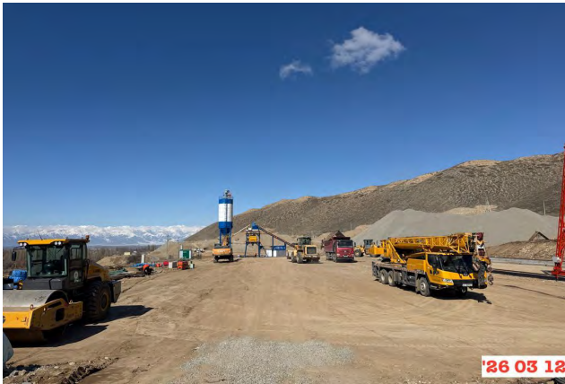
Фото 43. Участок 2, производственная база, на км.202+220
