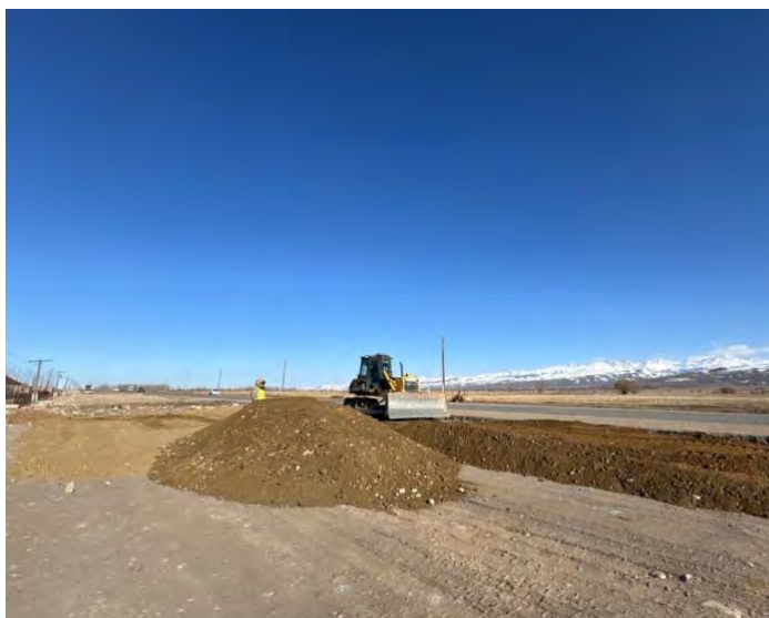
Фото 3. Участок 2. Земляные работы по устройству насыпи 197+400-198+200 LHS
