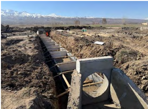
Фото 15. Км 212+611, монтаж в/пр сооружения
