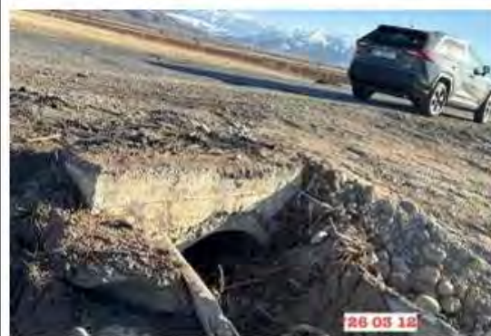
Фото 7. Водопроектная труба, на км.188+400 LHS, выход
