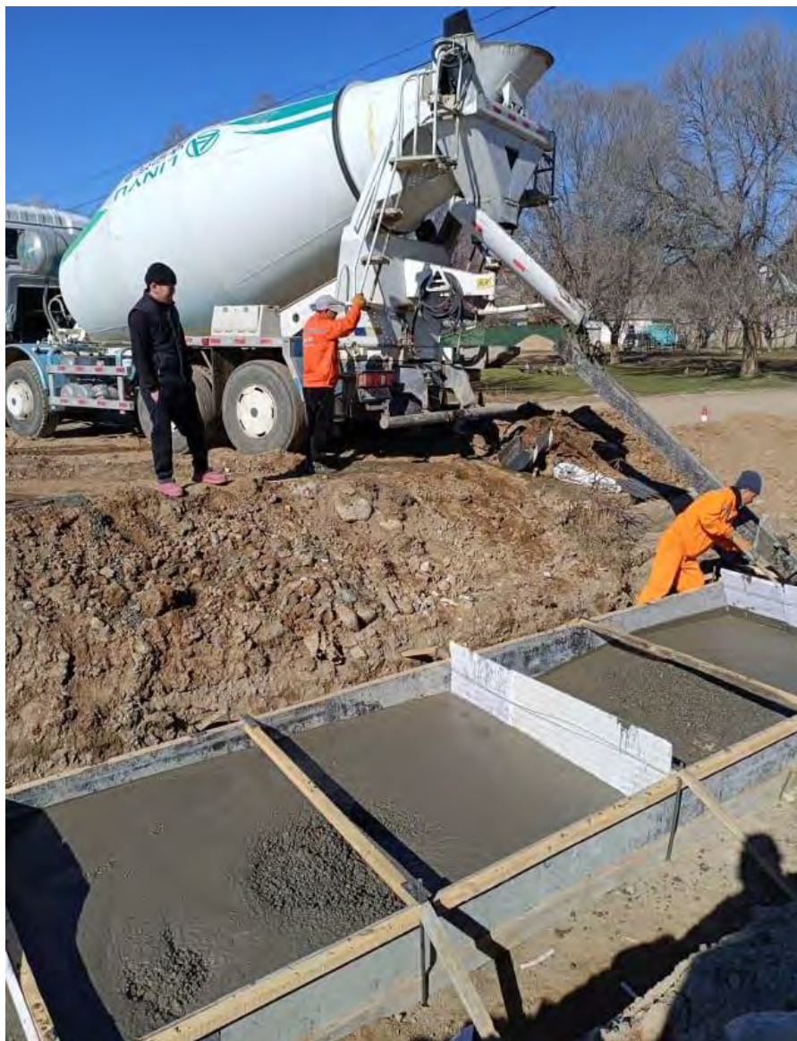
Рисунок 10: Заливка бетона в фундамент железобетонной трубы с отверстием 1,5 м с использованием бетона марки Б30 на участке км 196+097.
