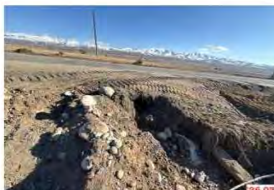
Фото 8. Водопроектная труба, на км.198 LHS, выход
