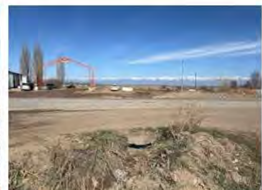
Фото 9. Водопроектная труба, на км.200+ RHS. вход
