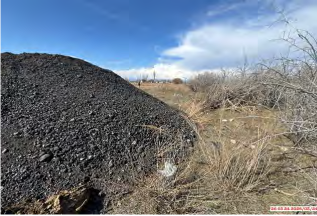
Фото 67. Отвал асфальта на км.199+500. Границы отвала не обозначены.
