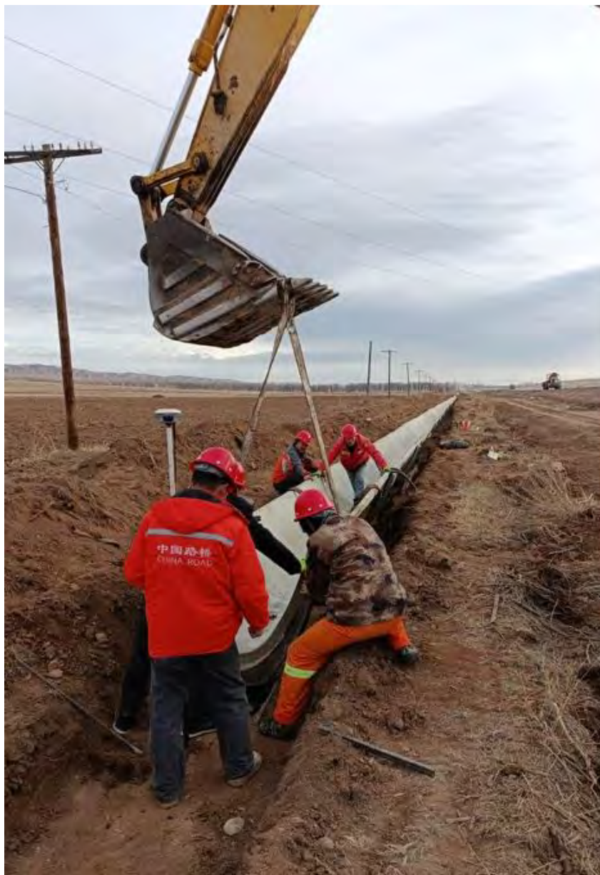
Рисунок 6: Установка лотков LR 6 на участке км 187+000 л.с.
