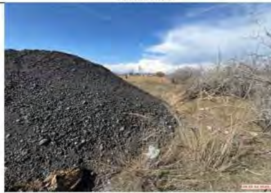
Фото 28. Отвал асфальта на км.199+500. Границы отвала не обозначены.
