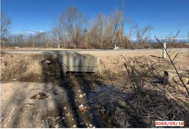
Фото 19. Селепропуск на км.151+020 RHS. вход
