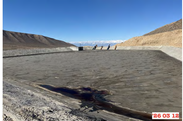
Битумохранилище на производственной базе км.202+220
