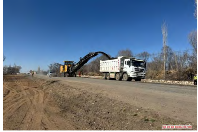
Фото 14. Фрезеровка асфальта км.203+300
