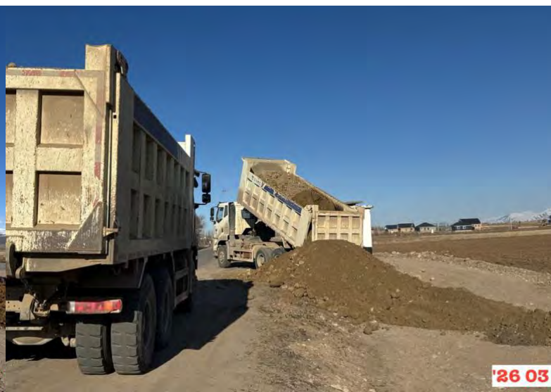
Фото 4. Участок 2. Участок 2. Земляные работы по устройству насыпи 197+400-198+200 RHS
