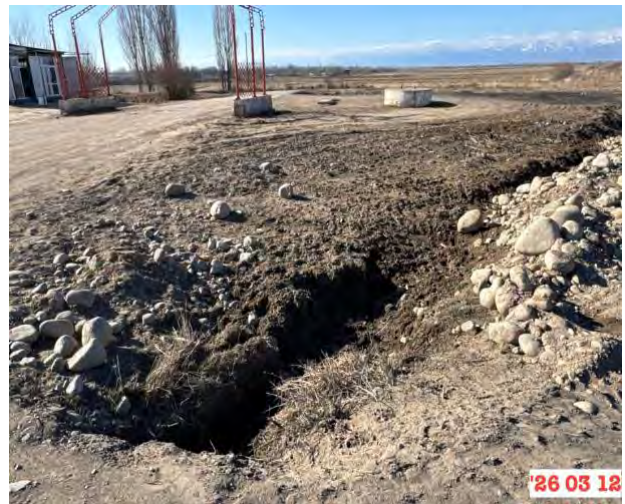
Фото 28. Водопропускная труба, на км.200+ RHS. Выход
