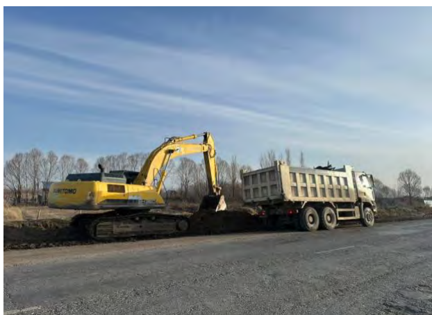
Фото 5. Расчистка и корчевание, км 204+880 LHS
