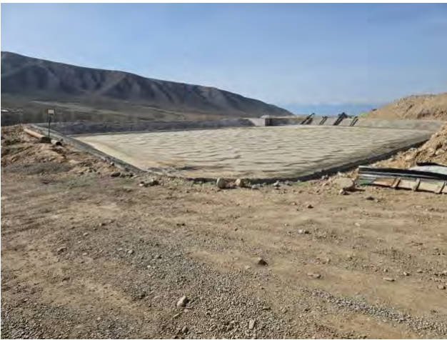
Битумохранилище на производственной базе км.202+220
