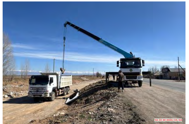
Фото 58 Вывоз демонтированных частей водопропускного сооружения на км. 194
