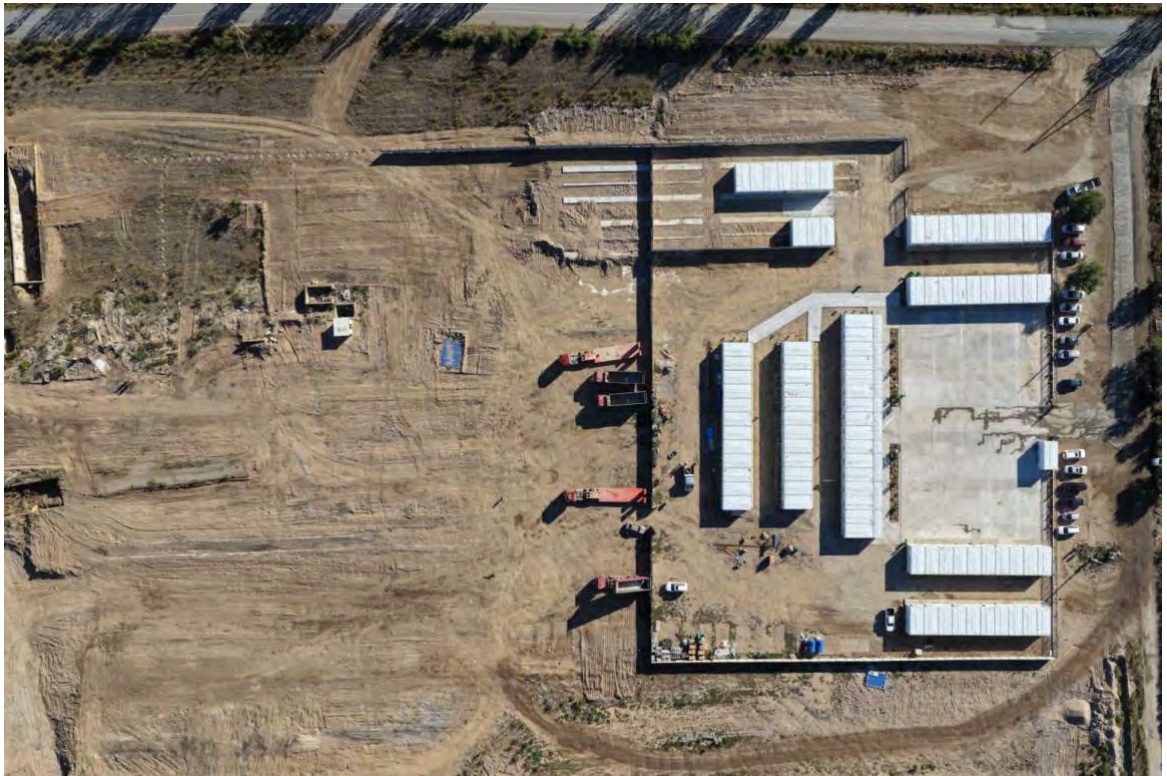
Рисунок 29: Вид сверху на территорию Лагеря в селе Чырак, км 199+460 ЛС (Лот 2)
