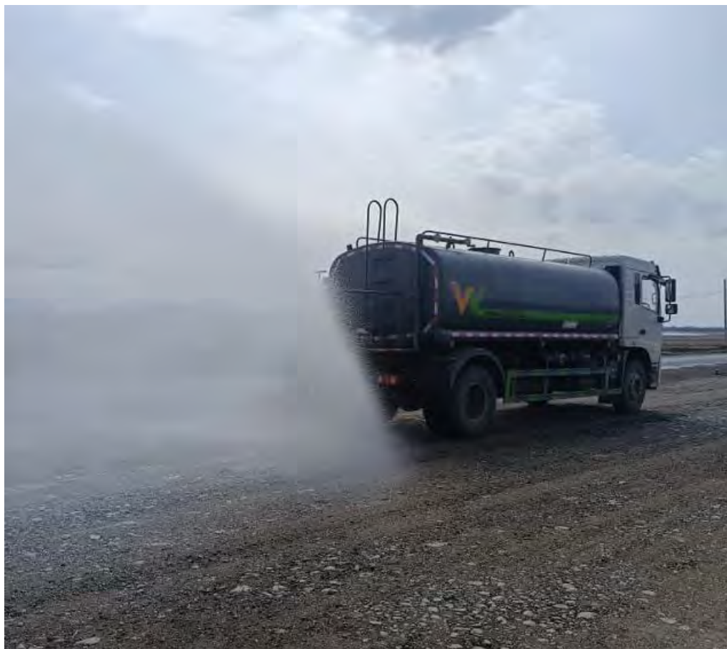
Рисунок 13: Пылеподавление строительных участков на км 198+000
