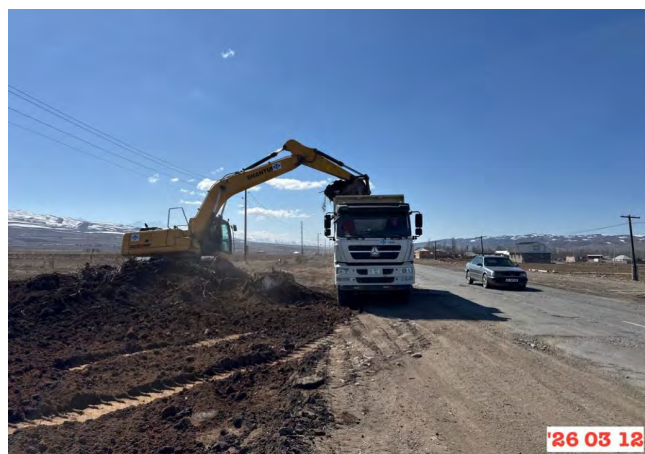
Фото 6. Расчистка и корчевание, км 198+400 LHS
