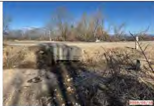
Фото 2. Селепропуск на км.151+020 RHS. вход
