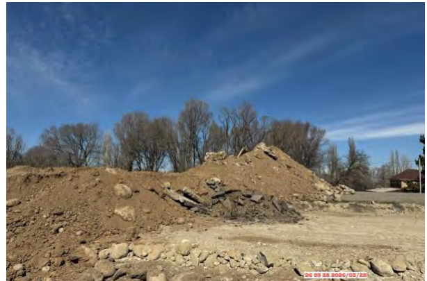
Фото 60. Складирование фрезерованного асфальта на строительных участках
