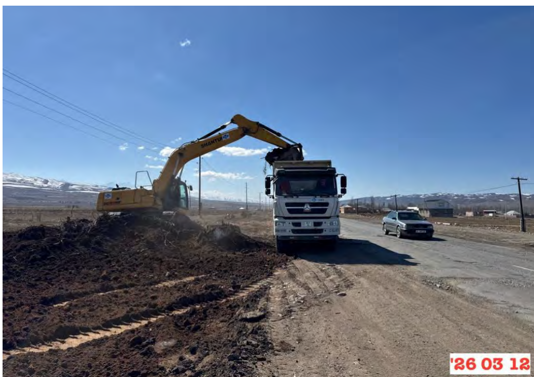
Рисунок 5: Расчистка и выкорчевывание расширенного участка насыпи на участке км 198+400 л.с.
