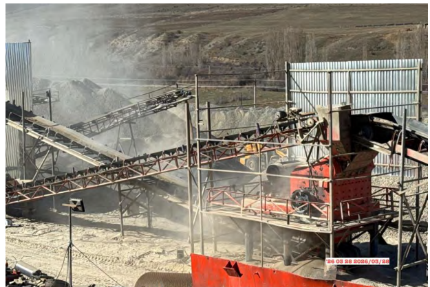
Фото 54. Производственная база, км.202+220 RHS, пылевыведение при работе ДСУ
