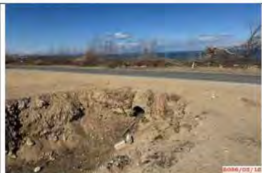
Фото 4. Селепроект на км.151+260 RHS. вход
