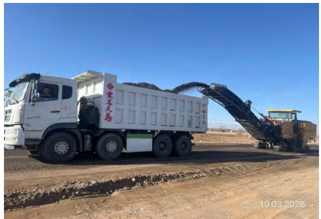
Фото 12. Фрезеровка асфальта, км 200
