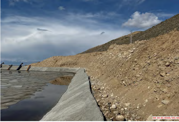
Битумохранилище на производственной базе км.202+220
